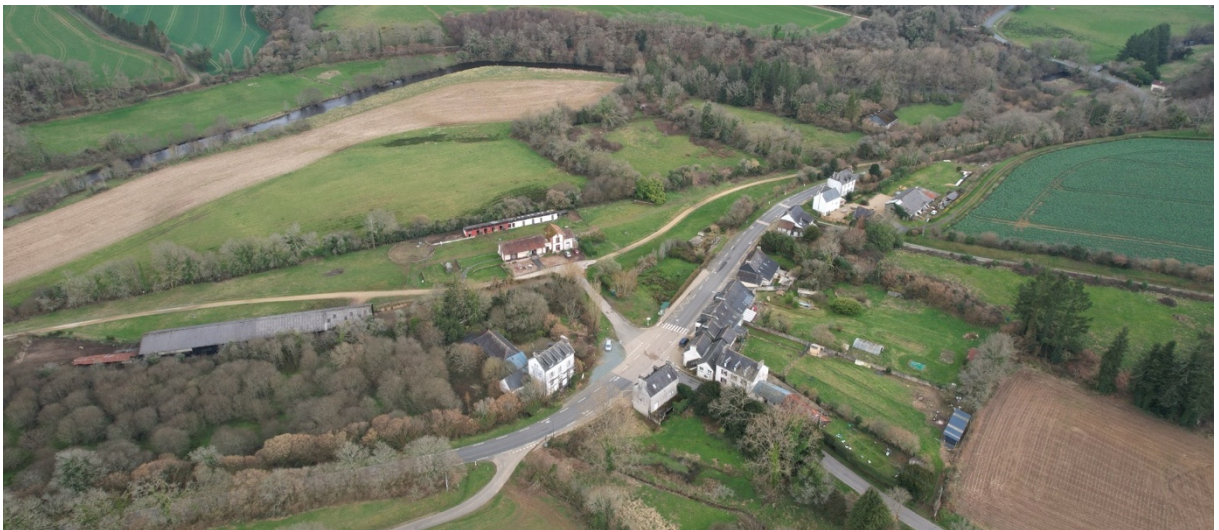
Vallée de l'Aulne, au lieu-dit Toul Trink : l'ancienne gare, visible au centre côtoie les espaces humides de fond de vallée, partiellement boisés.
