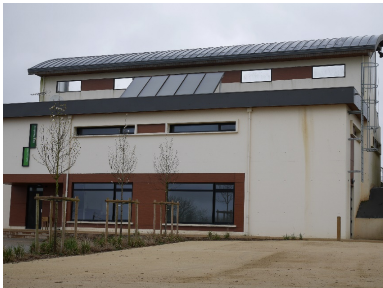
Panneaux photovoltaïques sur le complexe sportif et touristique de la commune. Source : Enamo
